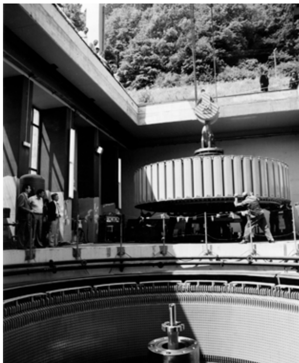
> Spuščanje turbine in rotorja generatorja v strojnico, septembra 1990
