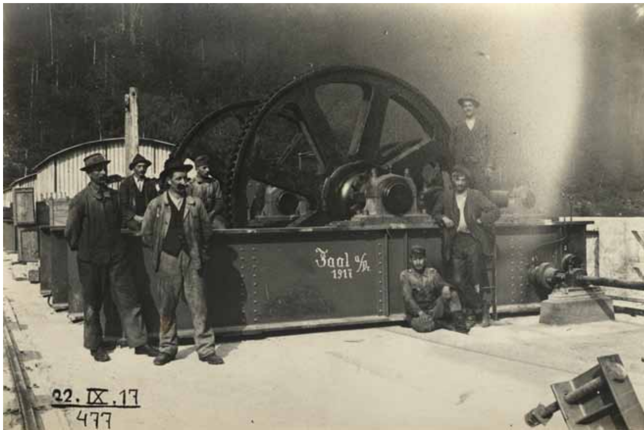
> Montaža pogonov jezovnih zapornic, 22. septembra 1917
