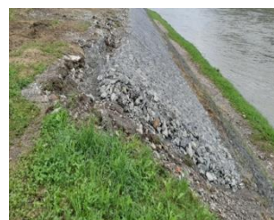
Lomljenec zložen v pocinkano mrežo
