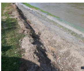
Zavarovanje brežine z gabioni – polaganje mreže
