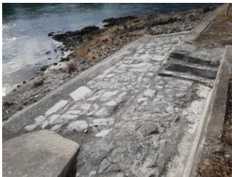
Podslapje hidroelektrarne Dravograd - levi breg
