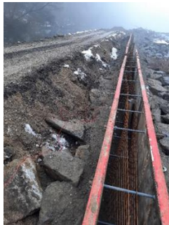
Pogled na opaž zidu
