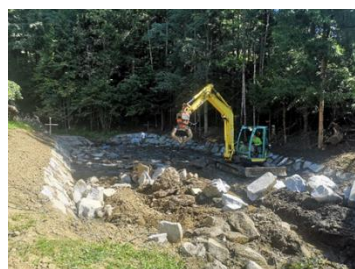
Kamnita betonska obloga struge Vaški potok
