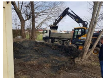
Začasna deponija odstranjenega materiala
