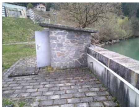
Merilno mesto, kjer je vgrajena oprema
