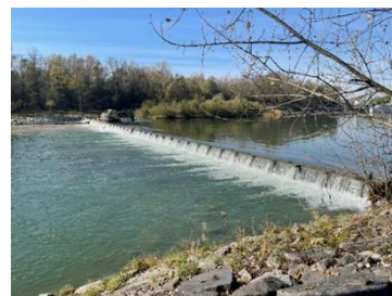
Saniran nizvodni prag jezcu Markovci
