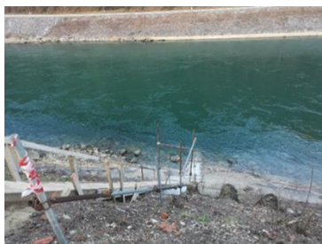
Izgradnja vodostaja na hidroelektrarni Fala
