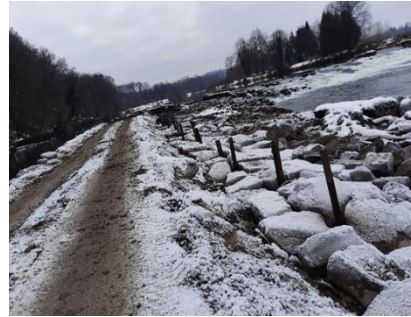
Pripravljene timice za potrebe opažanja zidu iz armiranega betona
