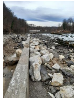
Izvedena tesnilna stena
