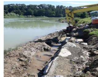
Izlivni odsek Meže - zaščita brežine
