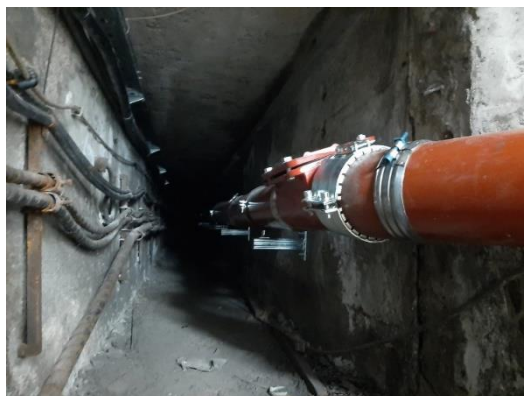
Izvedba povezav med objekti po kabelskih kanalih
