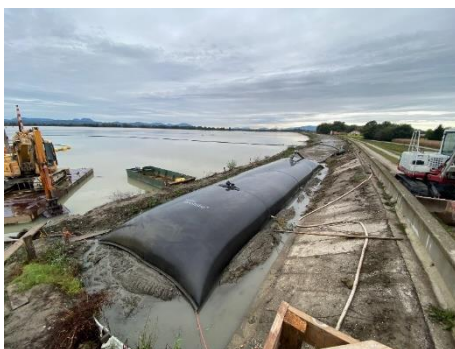
Revitalizacija levega brega z geotekstilnimi vrečami in kaštami
