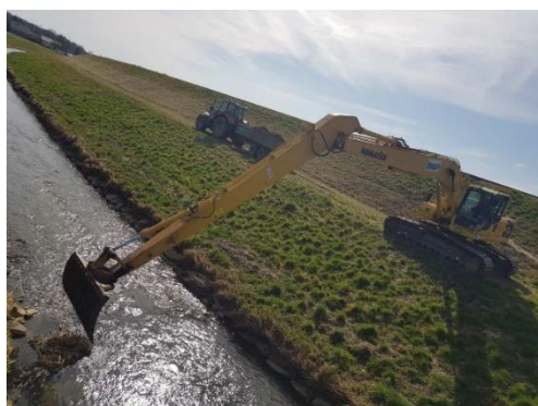
Odstranjevanje sedimentov in zarasti
