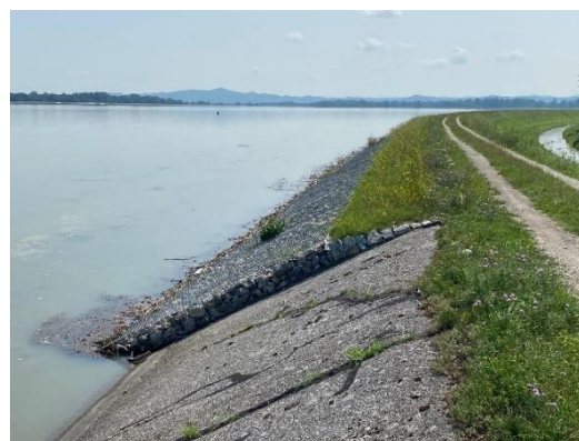
Zaščite brežine iz gabionov in mulja na desnem bregu
