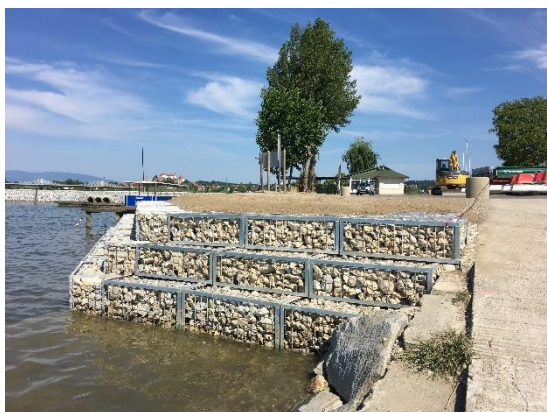
IZVEDBA ZAŠČITE BREŽINE NA LEVEM BREGU PTUJSKEGA JEZERA – PRI RANCI IN PREČRPVANJE MULJA NA DESNEM BREGU
