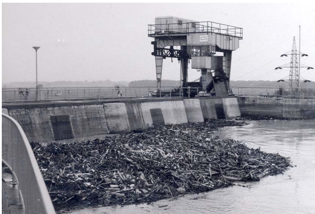
Plavje na turbinskem vtoku (foto: arhiv DEM)
