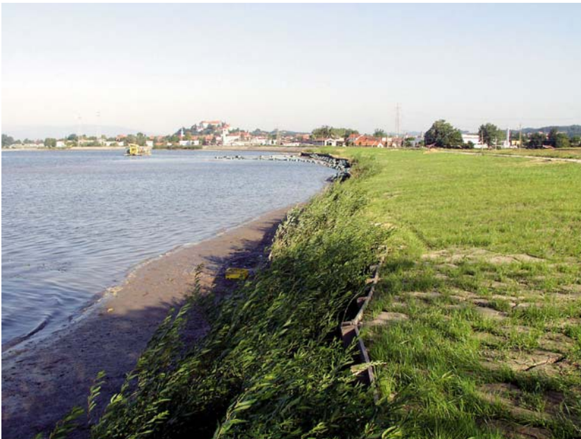
Urejena brežina po sanaciji (foto: arhiv DEM)
