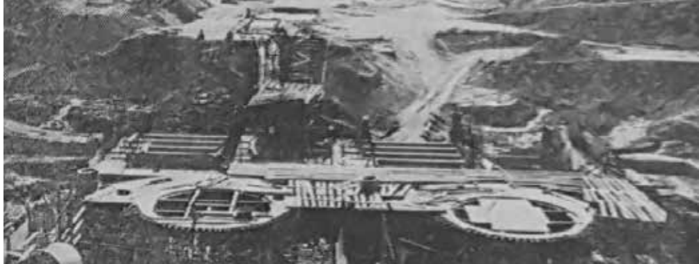
Strojnična zgradba med gradnjo in pogled na začetek dovodnega kanala
