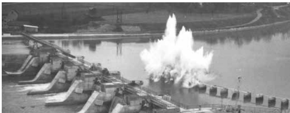
Gradnja jezua Melje; miniranje nosilnih stebrov za lesene zapornice gorvodne pregrade druge gradbene jame
