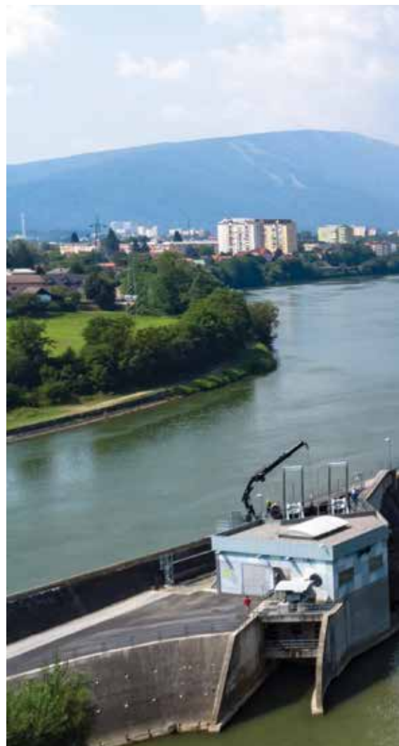
Jez Melje in mala hidroelektrarna Melje
