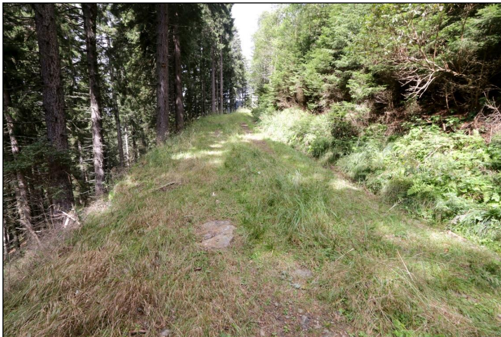
Slika 31: Obstoječa gozdna cesta na območju predvidene povezovalne ceste Za izgradnjo ustreznih transportnih poti za potrebe postavitve vetrne elektrarne na Ojstrici nad Dravsko dolino bo potrebno izvesti temeljito rekonstrukcijo obstoječih gozdnih prometnic. To bo zahtevalo močne posege v občutljiva gozdna tla in celotni gozdni prostor. (foto: L. Kutnar)
