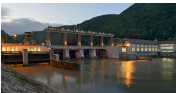
Hidroelektrarna Fala danes |
