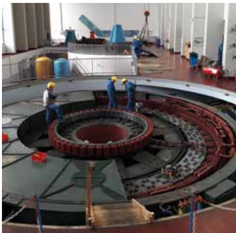
SLIKE PRIKAZUJEJO RAZLIČNE FAZE PODALJŠANE REVIZIJE AGREGATA A1 HIDROELEKTRARNE FORMIN.
