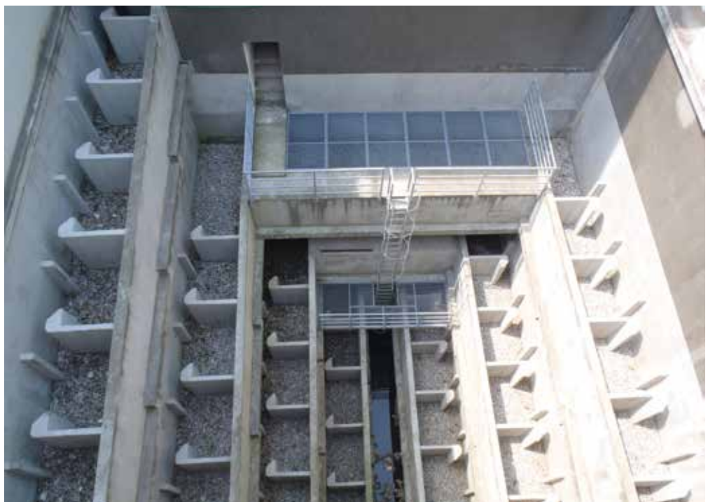
RIBJA STEZA PO SANACIJI
