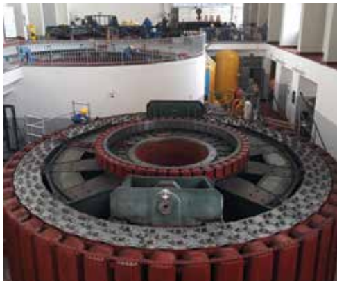
SLIKE PRIKAZUJEJO RAZLIČNE FAZE PODALJŠANE REVIZIJE AGREGATA A1 HIDROELEKTRARNE FORMIN.
