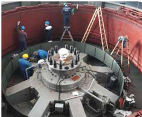
SLIKE PRIKAZUJEJO RAZLIČNE FAZE PODALJŠANE REVIZIJE AGREGATA A1 HIDROELEKTRARNE FORMIN.
