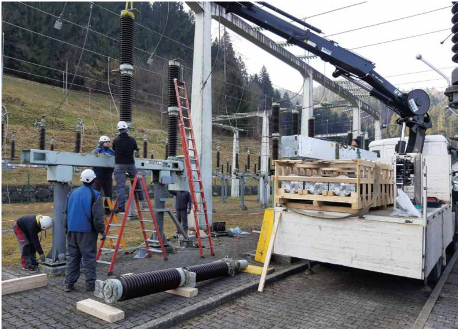
Sodelavci DEM med izvajanjem zamenjave.
