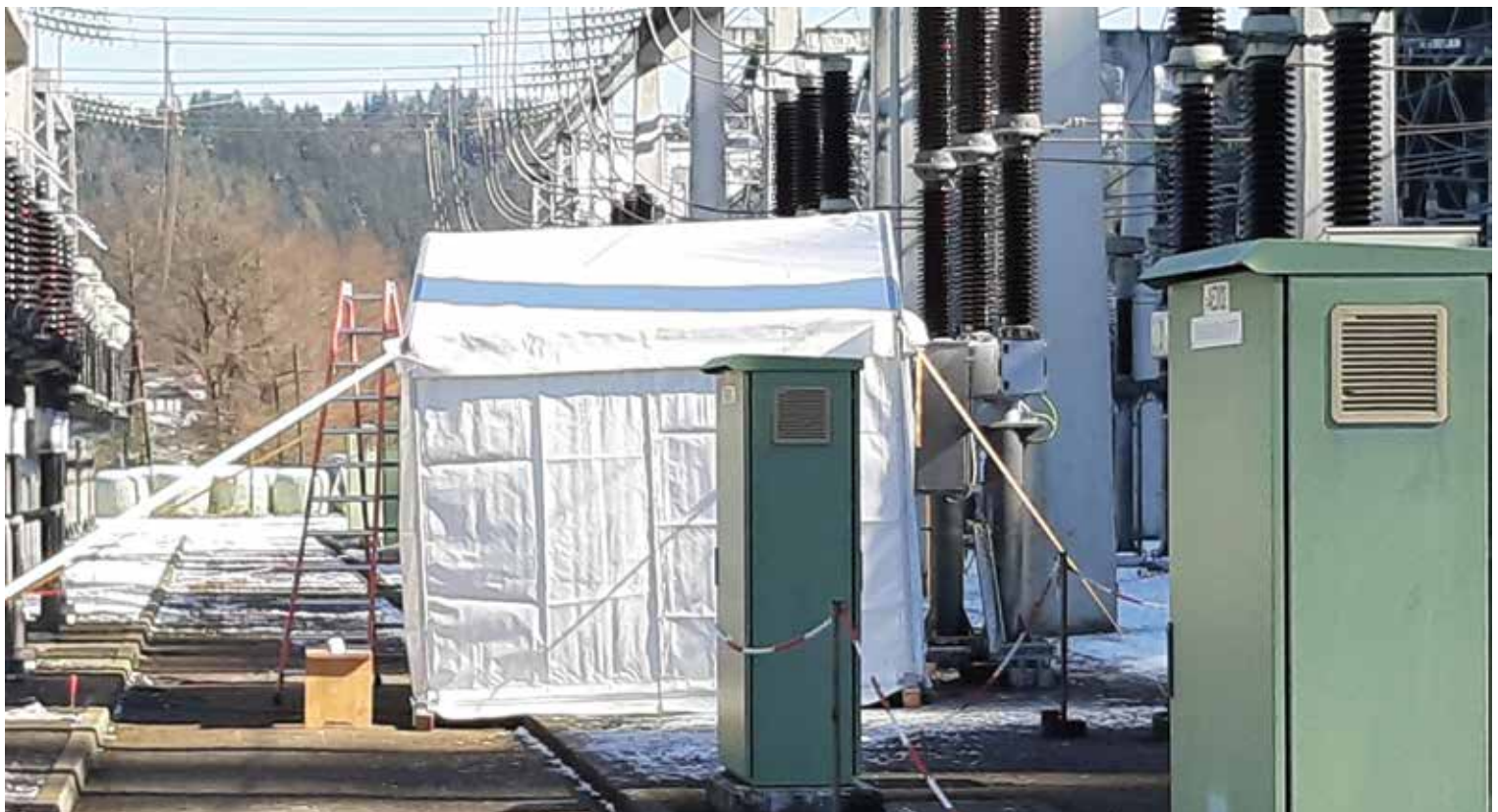
Projekt zamenjave se je začel, ko je bil še sneg in mraz.
