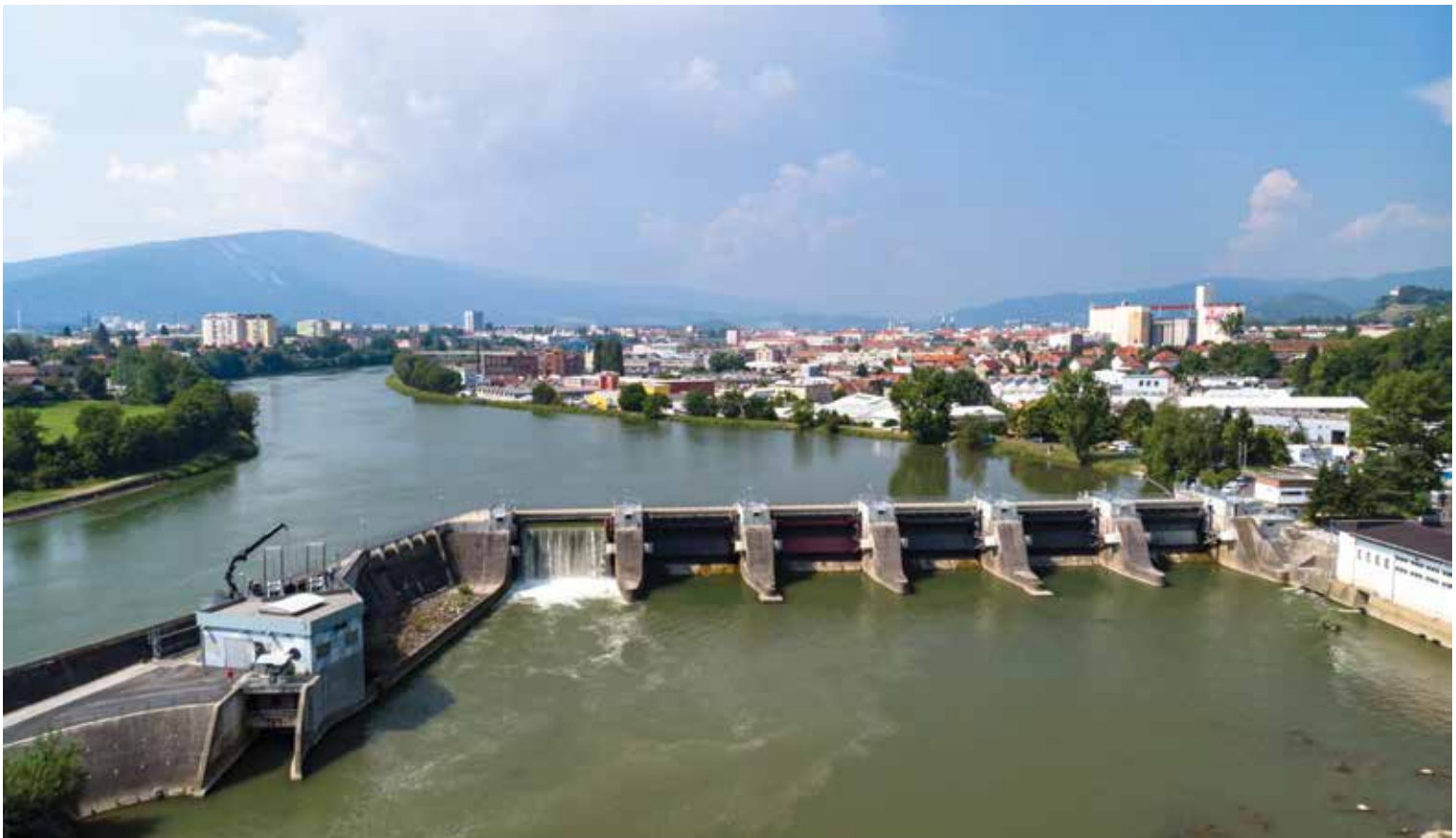
Izpad proizvodnje pri malih hidroelektrarnah je v največji meri posledica izpada agregata ena male hidroelektrarne Melje.
