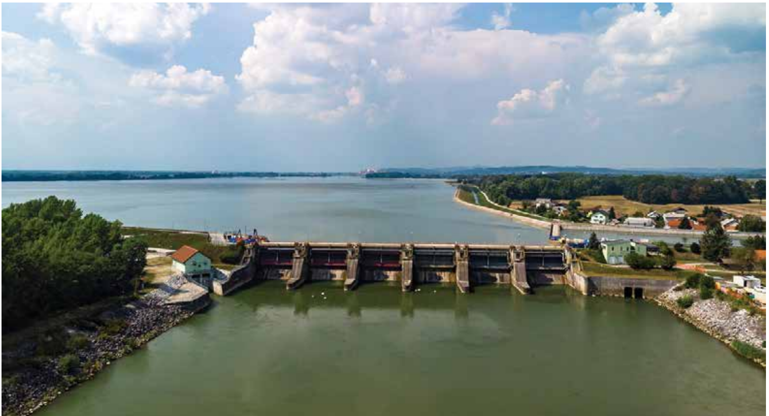
Na jezcu Markovci se je začela celovita prenova pretočnih polj.
