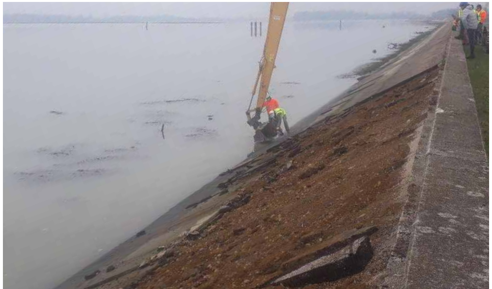
Odstranjevanje poškodovane obloge.
