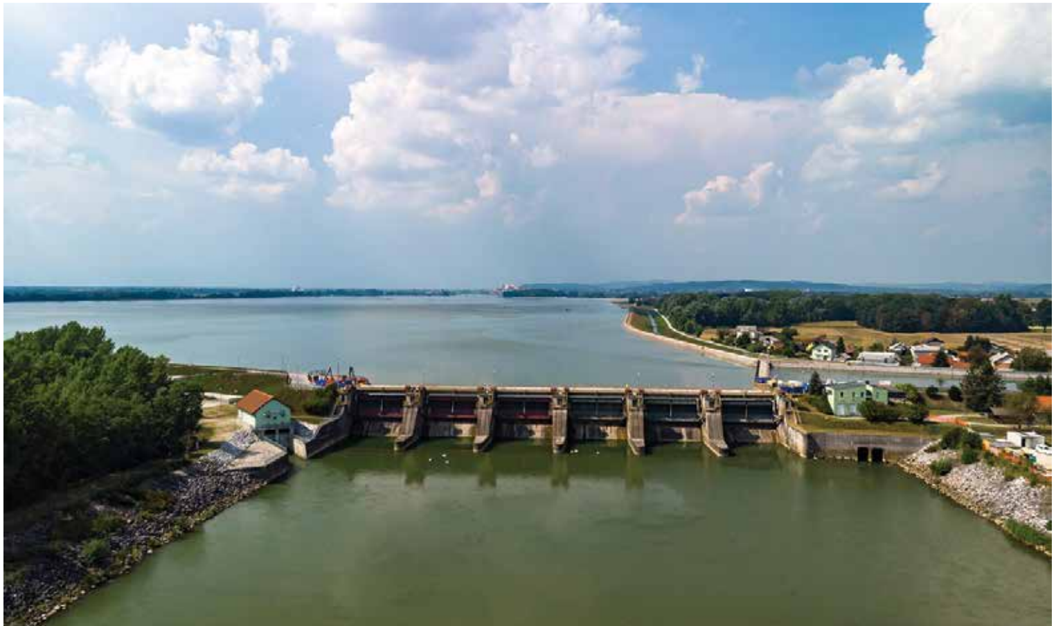
Jezcu Markovci, na katerem poteka prenova pretočnih polj.
