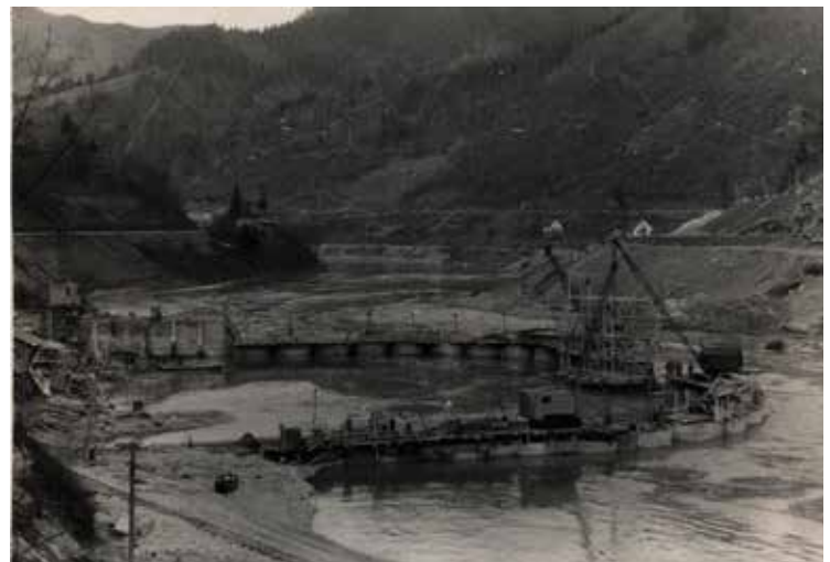
Opažanje prve gradbene jame; 1958
