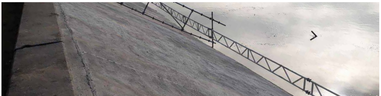
Zamenjava obloge z betonom.
