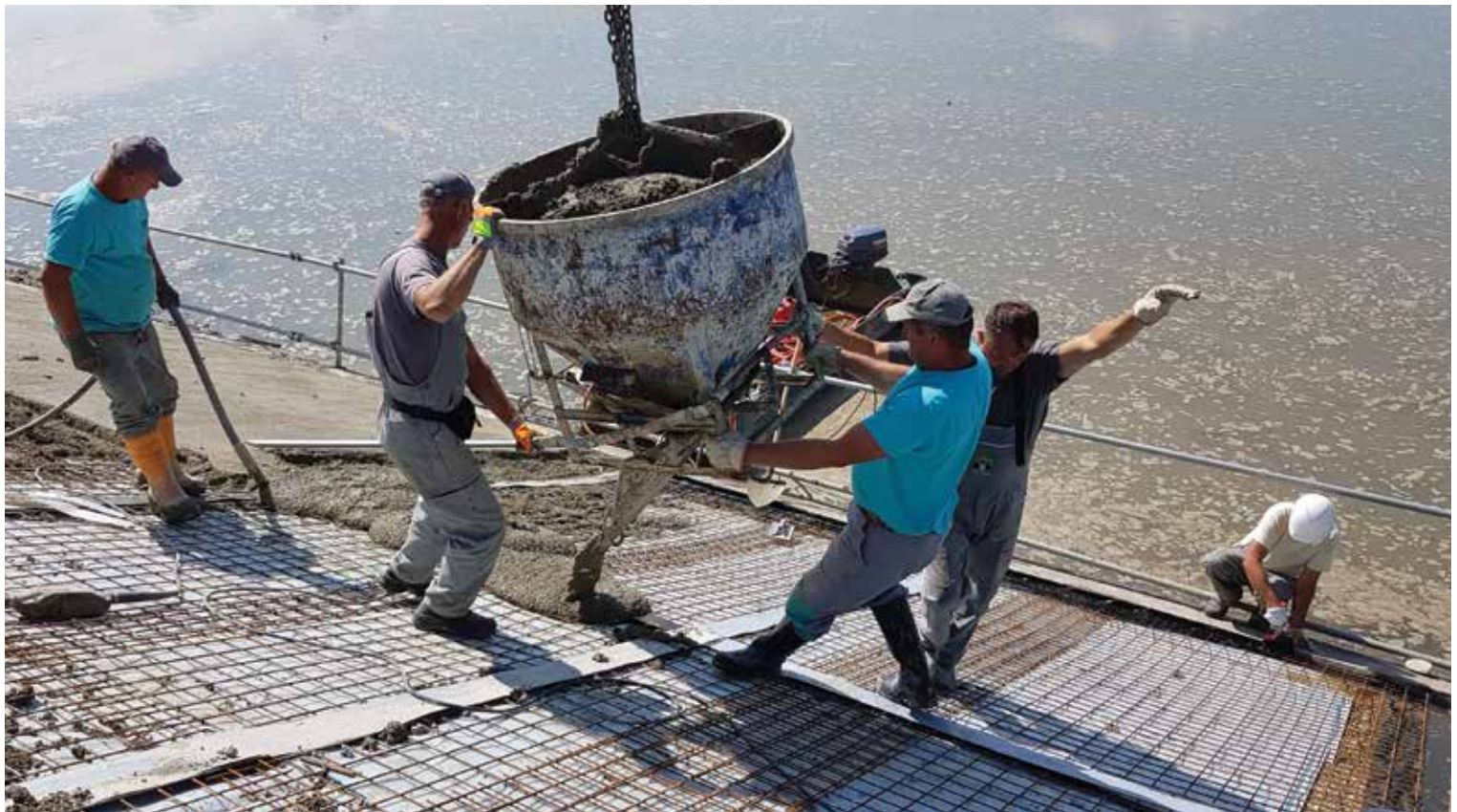
SANACIJA NAKLONSKIH POVRŠIN ASFALTNE OBLOGE PTUJSKEGA JEZERA JE POTEKALA POD BUDNIM OČESOM VODJE PROJEKTA, MIHE HORVATA.
